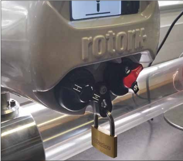
图 7.2. IQ 控制旋钮锁定在 "远程" 位置
